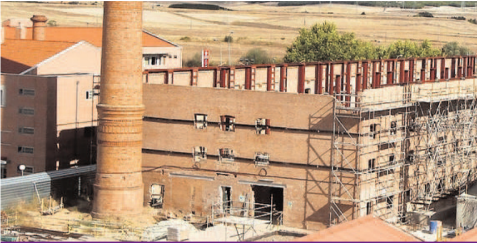
Obras de remodelación en la antigua Tejera de Palencia
